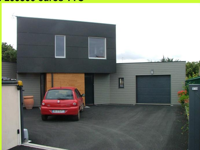
Isolation toiture : R de 7.37m<sup>2</sup>.K.W. ; Isolation des Murs : R de 7.1m<sup>2</sup>.K.W.
