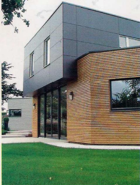
Dans cette maison à ossature bois, seul le volume de l'étage est porté par quatre piliers de béton. Son débord à l'avant limite les apports solaires directs dans la grande baie vitrée. À l'arrière, il forme un porche couvert pour l'entrée. L'architecture se singularise par des jeux de ligne très purs et rigoureux dans leur géométrie. Toutes les menuiseries bois-alu à haute performance sont dotées de volets roulants.
