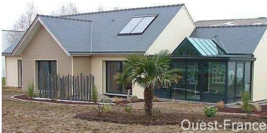
Pour l'élaboration d'une étape de la construction de la maison témoin « passive » à Fréhel, l'entreprise Richeux-Le Tohic a reçu un trophée 2010 de l'Habitat, signe révélateur d'un intérêt économique croissant qu'elle suscite.
