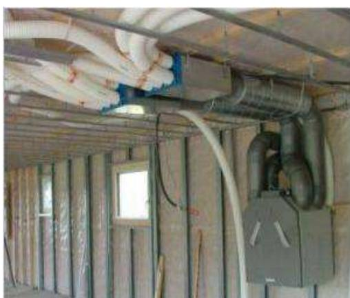
La VMC double flux assure la qualité de l'air à l'intérieur de l'habitation quelles que soient les conditions climatiques. Grâce à un échangeur de chaleur, la chaleur de l'air sortant sera "transmise" à l'air frais entrant sans que les flux d'air ne se mélangent.
