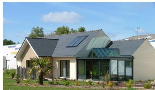
En construisant cette maison, j'avais un objectif : démontrer que l'utilisation d'un système de chauffage est aujourd'hui obsolète, dès lors que l'on applique quelques règles de bon sens pour isoler l'enveloppe du bâti. Devenue aujourd'hui témoin, cette maison repose sur un principe de construction très basse consommation grâce à une isolation renforcée, une étanchéité quasi parfaite et à une ventilation peu déperditive.
