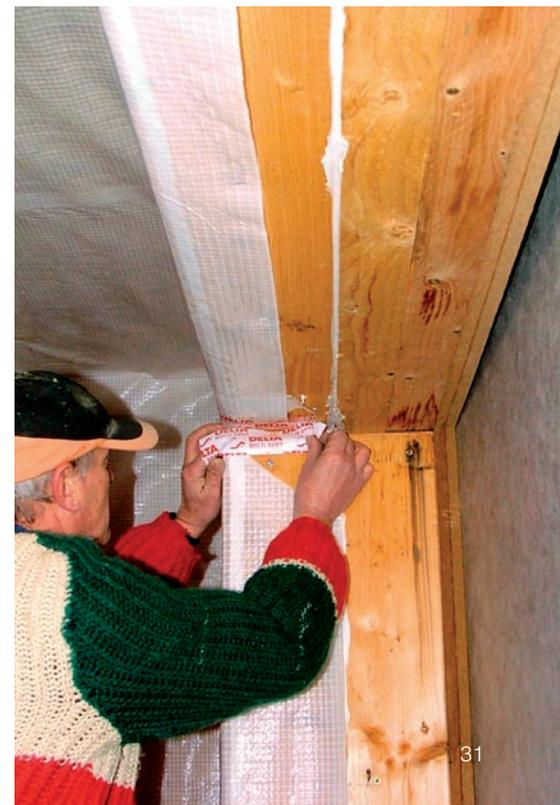
Pose du pare vapeur avec des adhésifs spécifiques. L'étanchéité à l'air est une nécessité impérieuse pour limiter les besoins de chauffage. La maison doit pouvoir respirer, mais la ventilation est contrôlée par la VMC double flux qui récupère les calories de l'air évacuée pour préchauffer l'air entrant et le répartir dans tout le volume.
