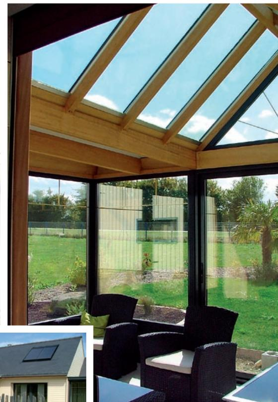
Au sud, la véranda de 18 m<sup>2</sup> est entièrement vitrée dans une charpente en movingui. Elle participe au confort thermique, grâce aux apports solaires d'une serre. Au quotidien, c'est un espace lumineux, agréable à vivre.
