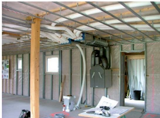
Pose de la VMC dans l'épaisseur du plafond. Le seul système de chauffage de la est installé dans l'enveloppe chauffée. Il ne passe pas par les combles froides pour limiter les déperditions.
