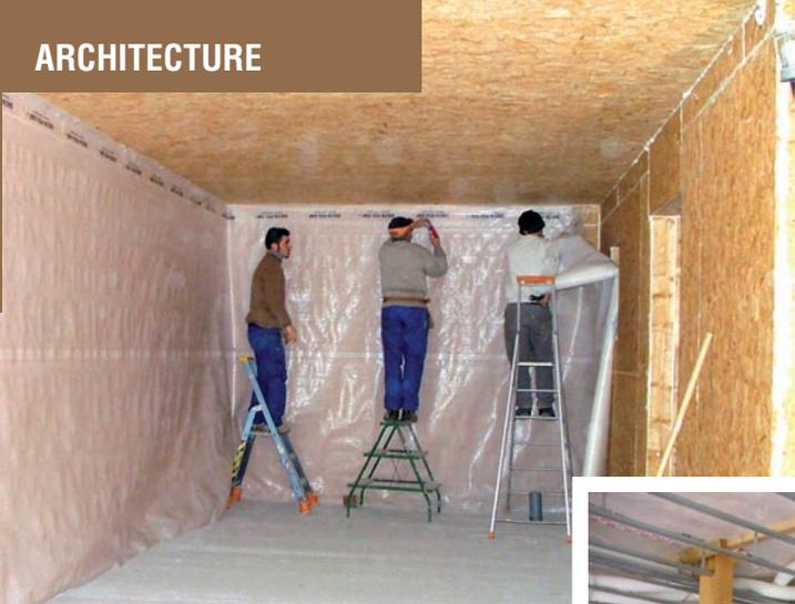
Aucun percement dans le pare-vapeur qui couvre toutes les parois périphériques. Dany Le Tohic a fait passer toutes les gaines électriques dans les cloisons intérieures, avec un seul point de passage pour l'arrivée du courant.
