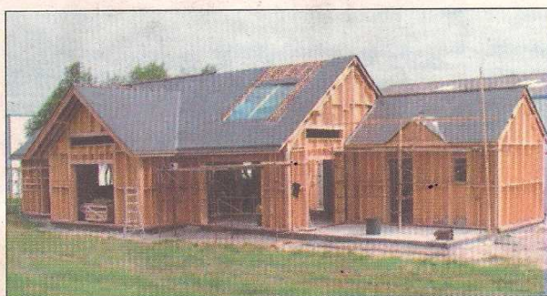
Maison passive à Ossature bois construite par l'ensemble des salariés de l'entreprise
