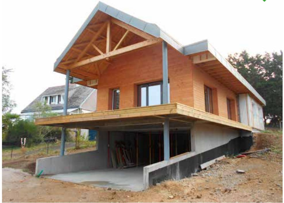
Le bardage en cours de pose. A l'arrière, des panneaux composites viendront compléter le parement avec de la couleur.
