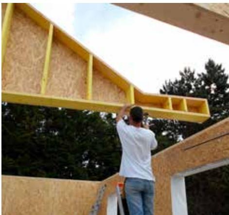
*Les murs et pignons parviennent sur le chantier équipés du pare-pluie et de l'ossature secondaire du bardage. Quelques jours suffisent pour monter la structure.*
